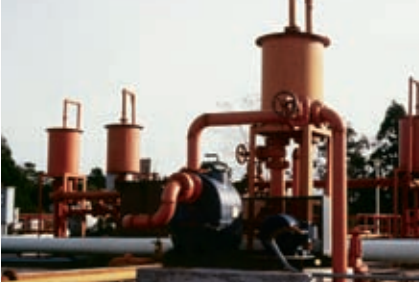
余剰汚泥移送
