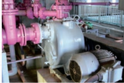
濃縮汚泥移送
